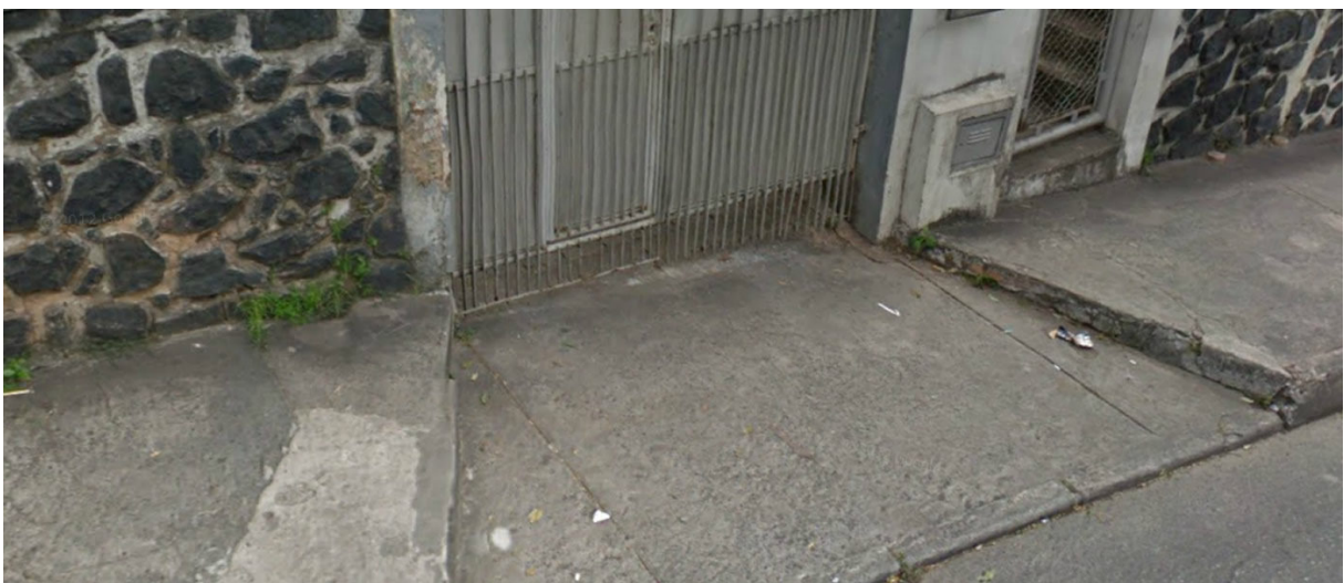
Figura 4.11 - Problemas de acessibilidade ao Ambulatório exemplo 4. Fonte: Autor (2012).
