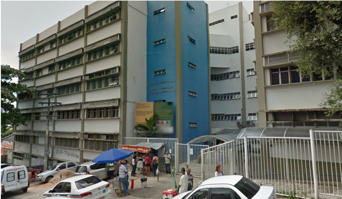
Figura 4.2 - Faixada do Pavilhão de Ambulatórios Magalhães Neto.
