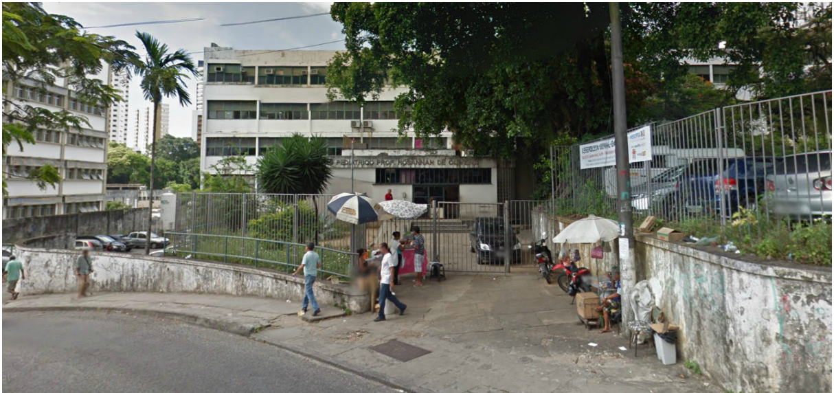
Figura 4.8 - Problemas de acessibilidade ao Ambulatório exemplo 1. Fonte: Autor (2012).
