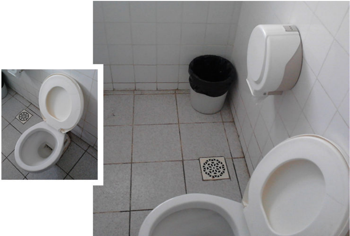
Figura 4.24 – Ausência sistema de apoio nos sanitários. Fonte: Autor (2012).
