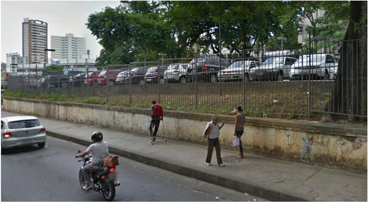
Figura 4.14 - Problemas de acessibilidade ao Ambulatório exemplo 7. Fonte: Autor (2012).
