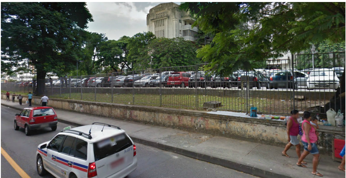
Figura 4.15 - Problemas de acessibilidade ao Ambulatório exemplo 8. Fonte: Autor (2012).
