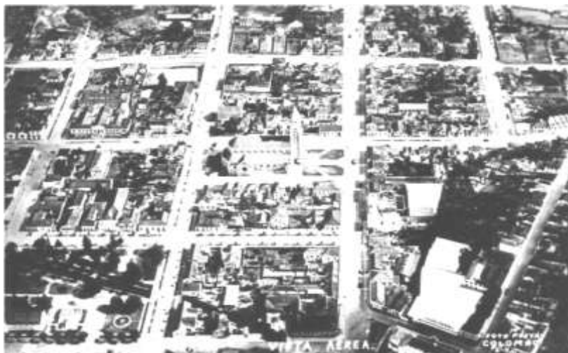
Figura 1 e 2- Vista aérea e Panorama do centro de Poços de Caldas por volta de 1945.
