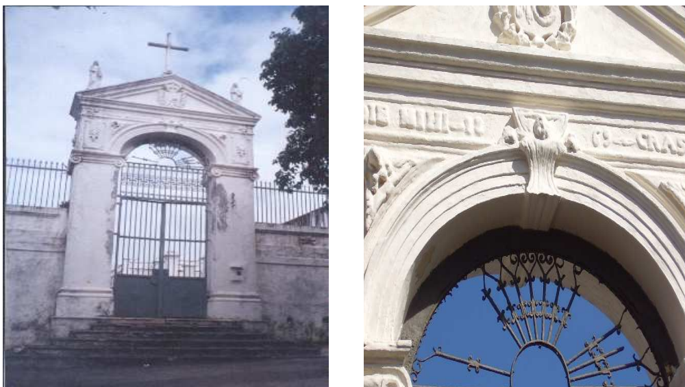
Figura. 101 e 102. Pórtico de Entrada com inscrição em Latim. A. P. 2006.
