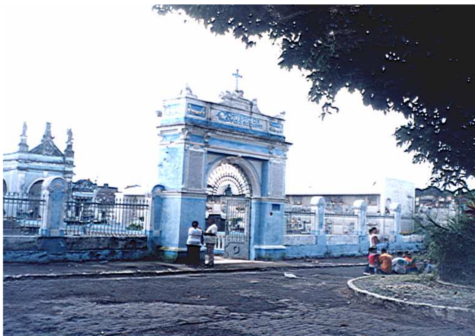
Figura. 187. Fachada atual do Cemitério da VOTC. A. P. 2006.
