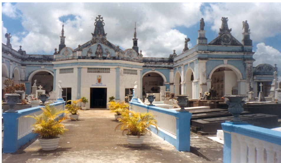
Figura. 192. Vista do interior do CVOTC. A.P. 2004.
