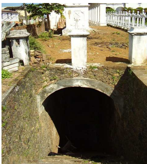
Figura. 146. Acesso ao subterrâneo do crematório. A. P. 2006
