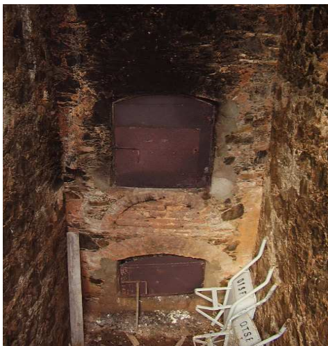
Figuras 147 e 148. Parte subterrânea do crematório e escadaria interna de quatro metros de profundidade (local de entrada de carrinhos de mão e de saída de material cremado). A. P. 2006.
