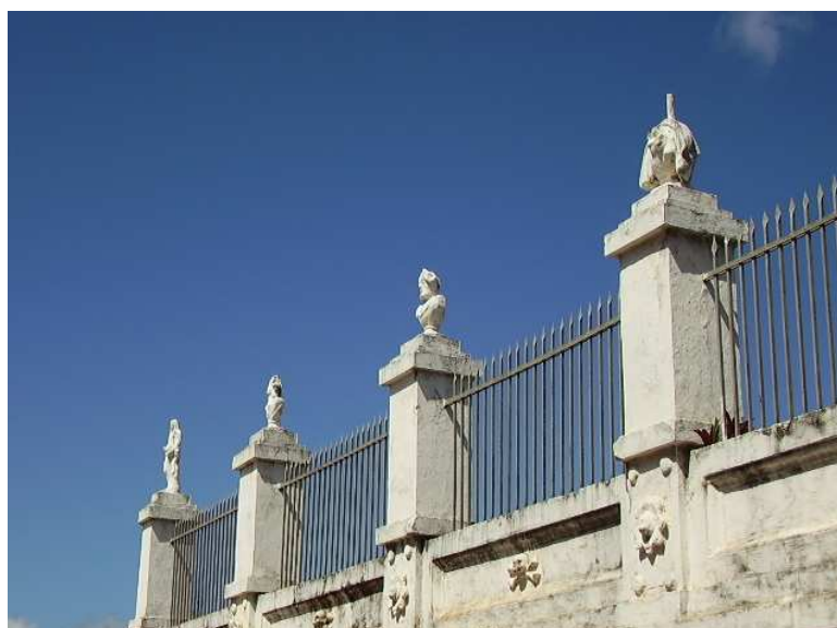
Figura. 95. Murada de proteção. A. P. 2006
