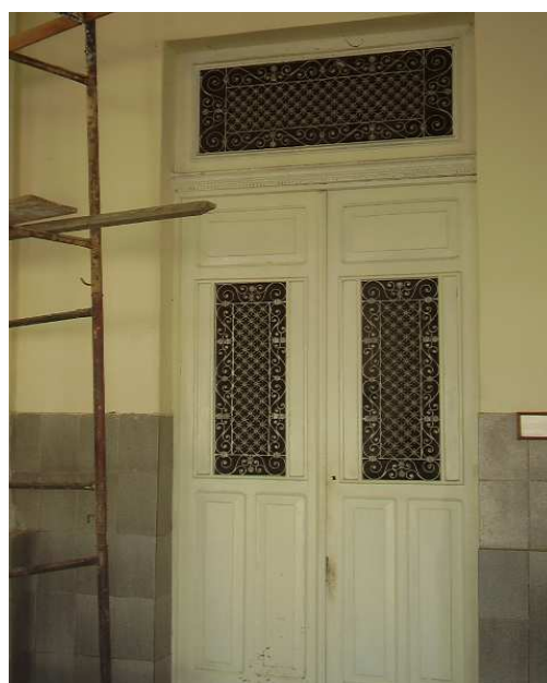
Figura. 208. Porta de acesso à Capela com gradil. A.P. 2006.
