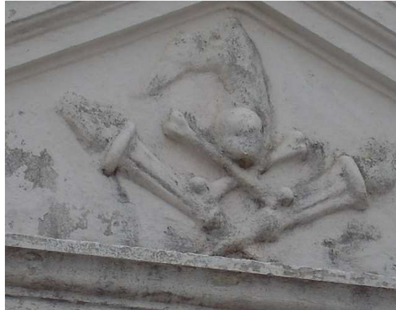
Figura. 107. Parte interna do pórtico de entrada. A. P. 2006
