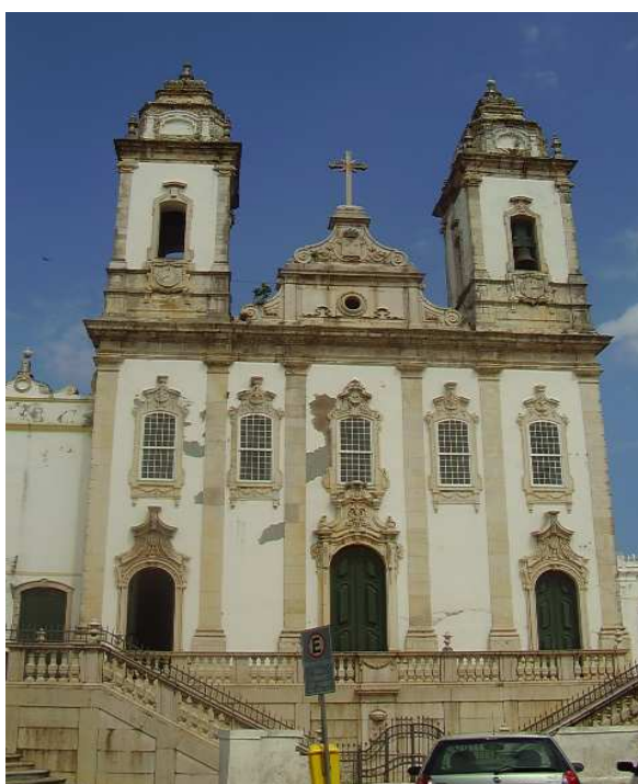
Figura. 186. Igreja da Venerável Ordem Terceira do Carmo. A. P. 2006.
