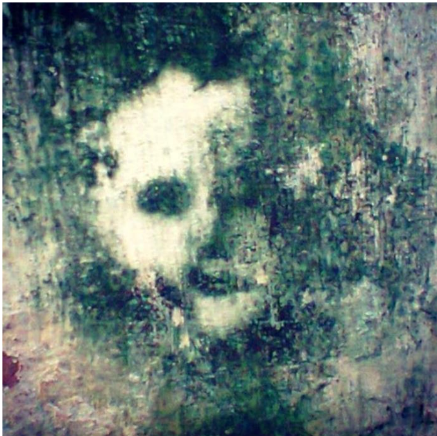
Figura 59 - Exemplo de pareidolia: mancha no muro
