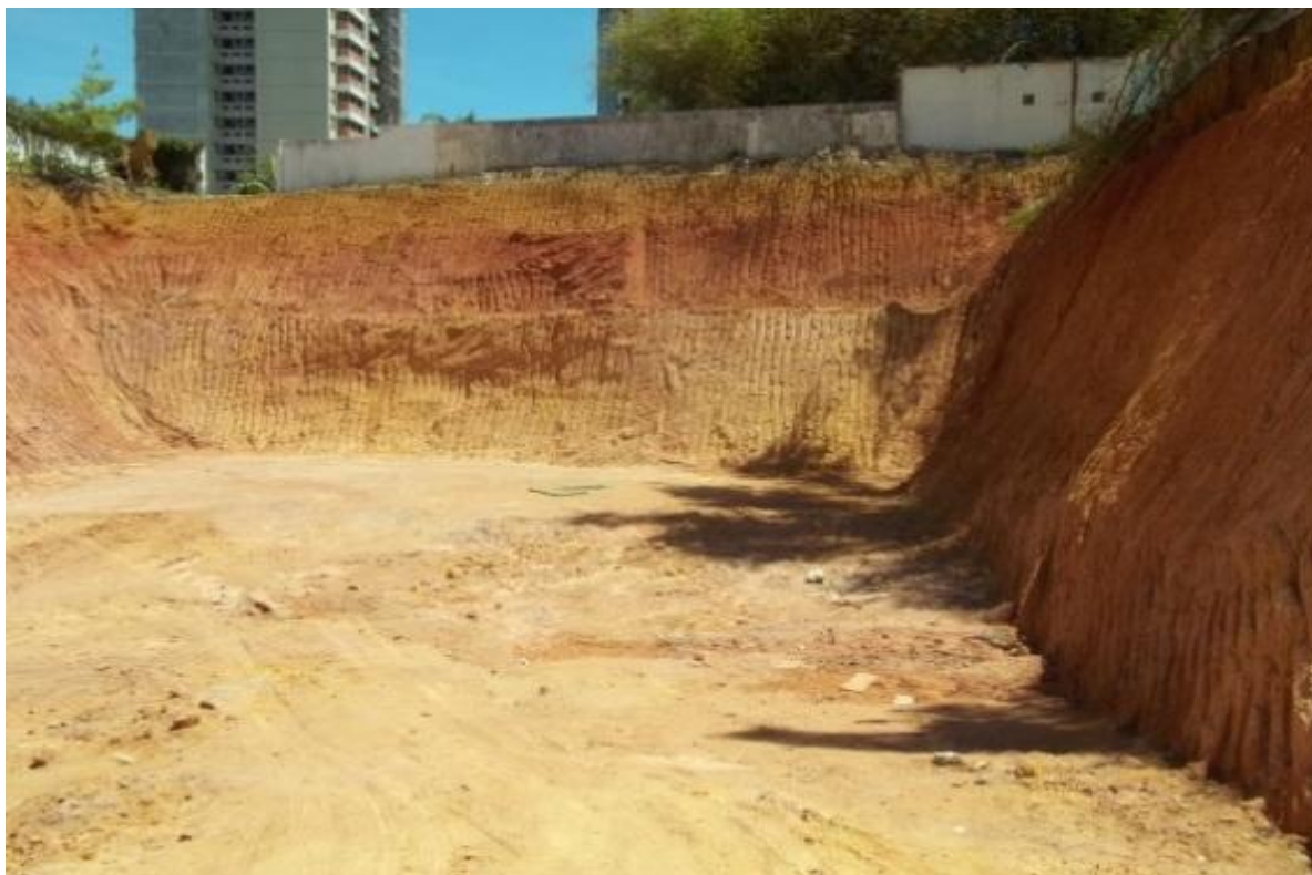
Imagem 32 - Terraplenagem em Patamares, 2012.
