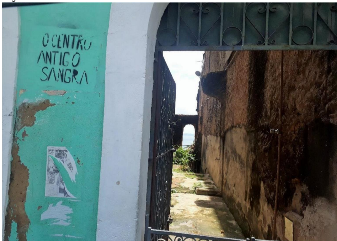
Figura 33 - Entrada de um terreno em ruínas. Bairro: Santo Antonio
